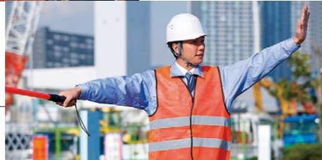
建設・工事現場でも
